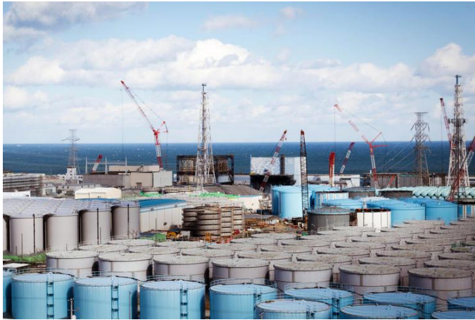
装载核废水的储罐，在储罐后面分别为一号和二号反应堆
