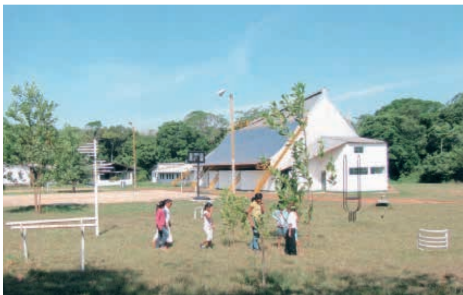
Aspecto parcial del centro las GAVIOTAS Vichada
