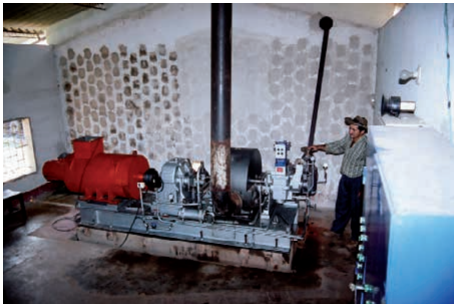
Turbina GAVIOTAS alimentada por vapor de madera para generación eléctrica. En la actualidad esta se hace en un 100% con biodiesel de pino tropical caribe
