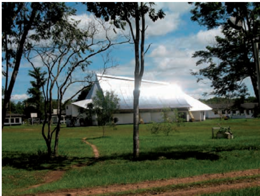
Aula múltiple bioclimática con techo reflectivo
