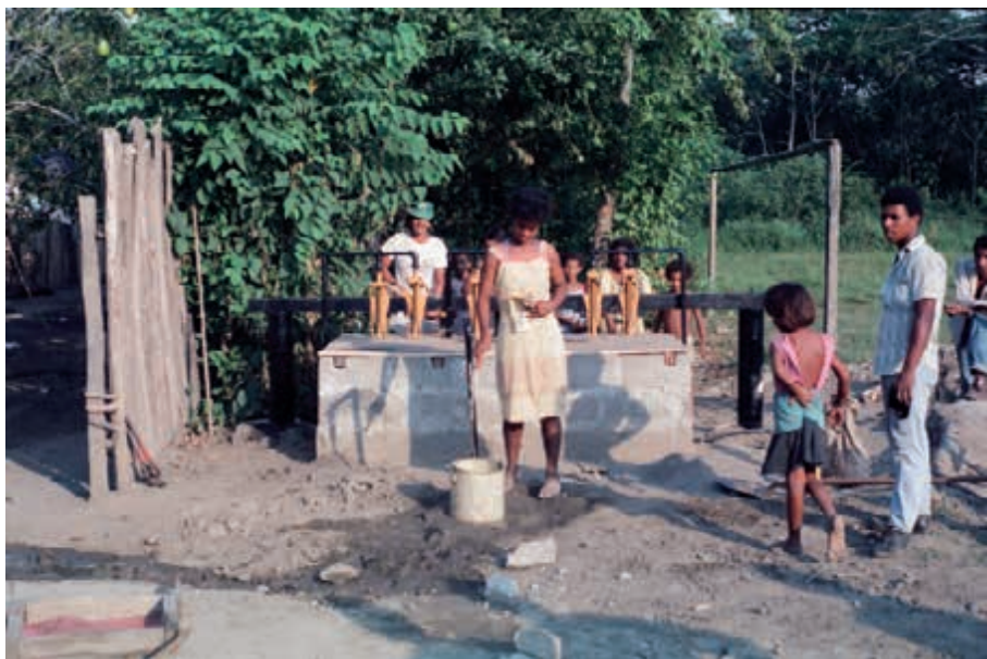
Microacueducto rural utilizando bombas de camisa GAVIOTAS
