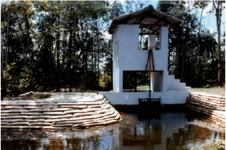
Presa y casa de máquinas de la turbina hidráulica GAVIOTAS de baja caída para generar electricidad
