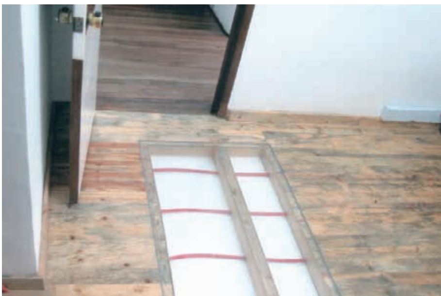
Calefacción ambiental solar por piso radiante en las oficinas de GAVIOTAS en Bogotá
