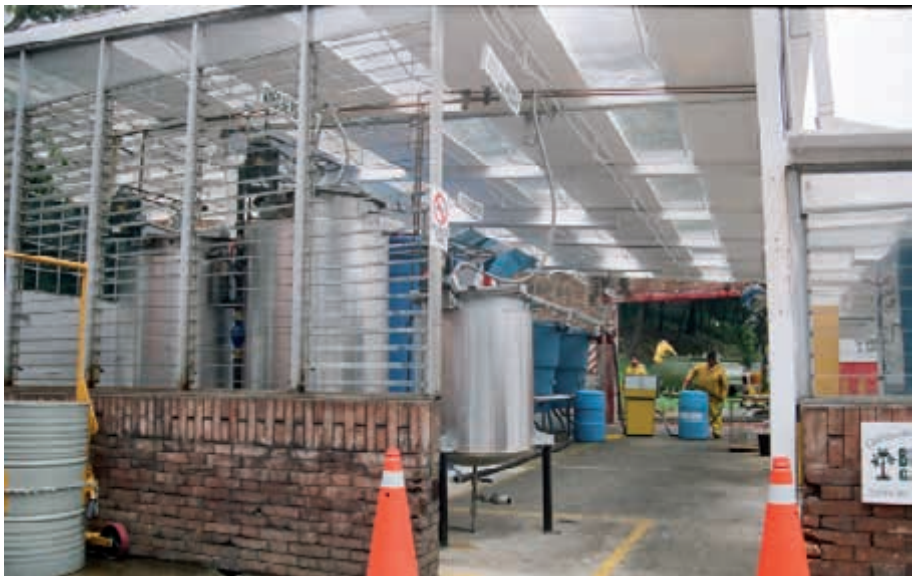
Planta de biodiesel tipo GAVIOTAS utilizando aceite crudo de palma africana, ubicada en Bogotá, actualmente el biodiesel se extrae de la oleorresina de pino tropical caribe
